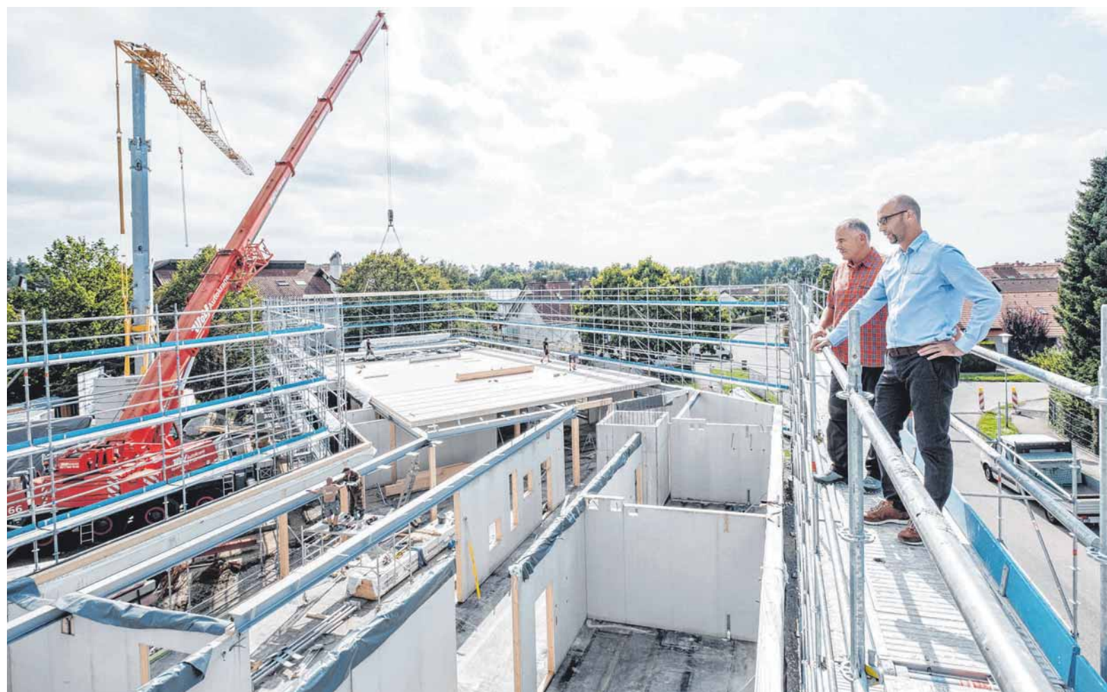
Thomas Steinhauser von der Stadt Tettang (links) und Thorsten Wiest vom Generalübernehmer Weizenegger Objektbau aus Bad Wurzach besichtigen die Baustelle.
